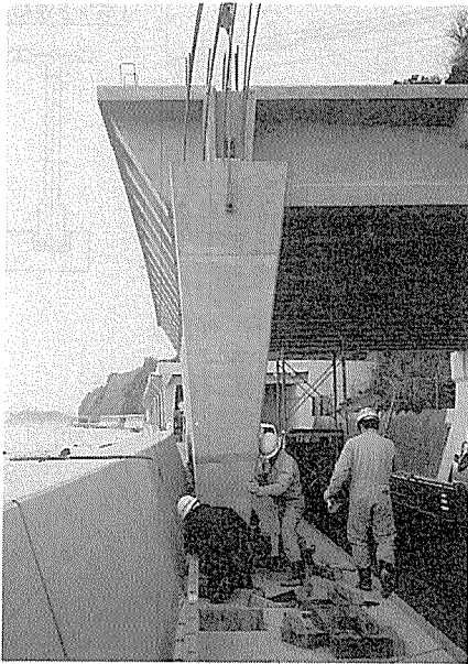
写真-3 柱架設
