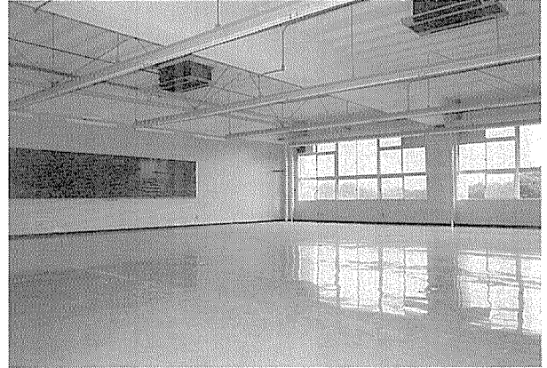
写真-6 FC板直仕上げによる施行例(教室)
