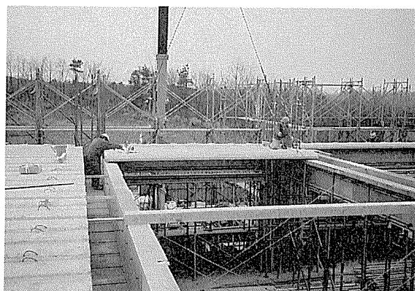
写真-3 FC板の敷設
