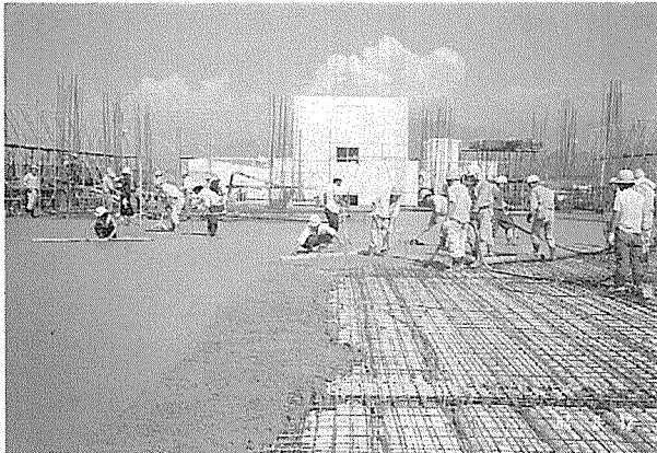
写真-5 場所打ちコンクリートの打設
