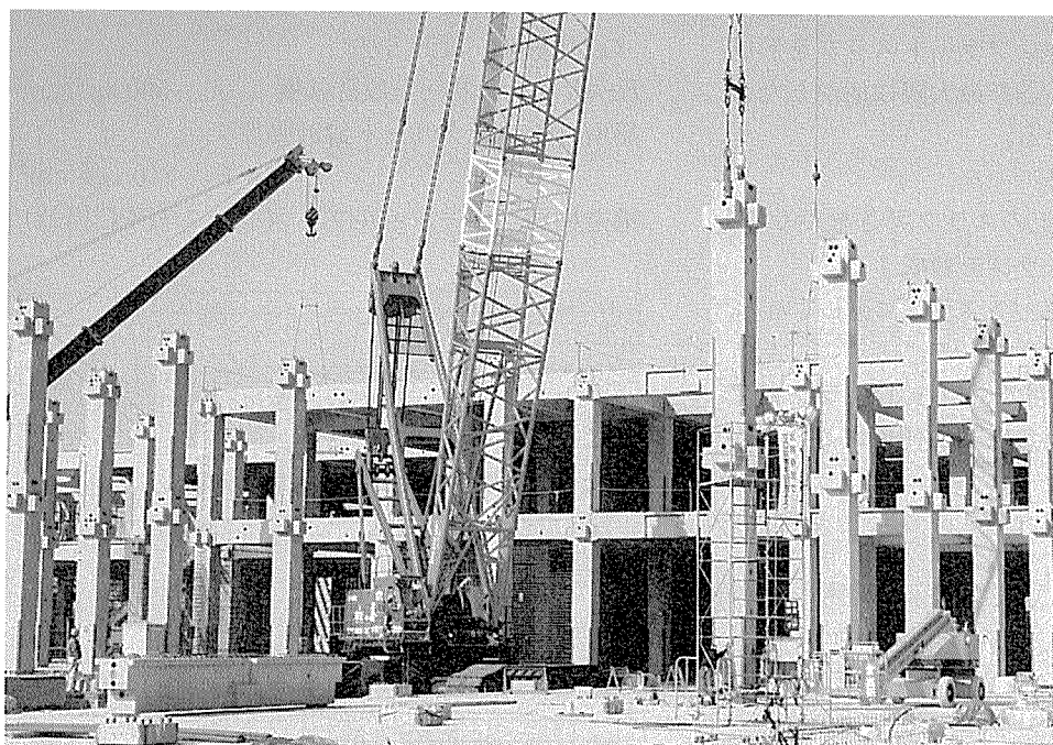
写真-2 DV板の架設
