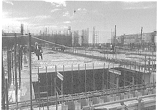
写真-2 ニチレイ船橋第2工場施工状況
