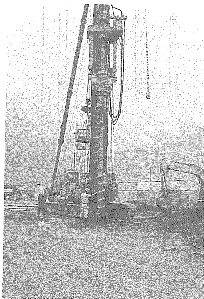
写真-2 AJパイル貫入施工状況
