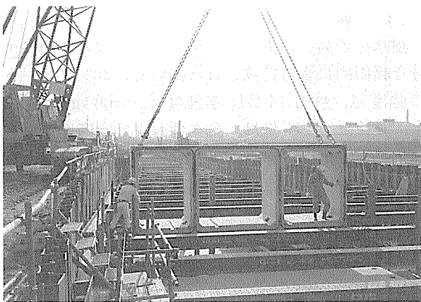
写真-1 据付け状況
