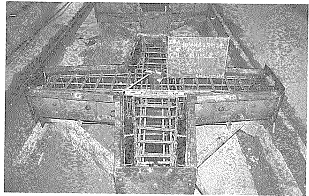
写真-1 PCフレーム製造状況
