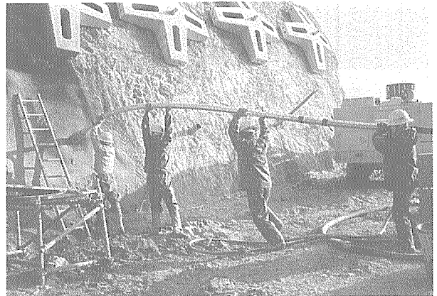
写真-4 アンカー体挿入
