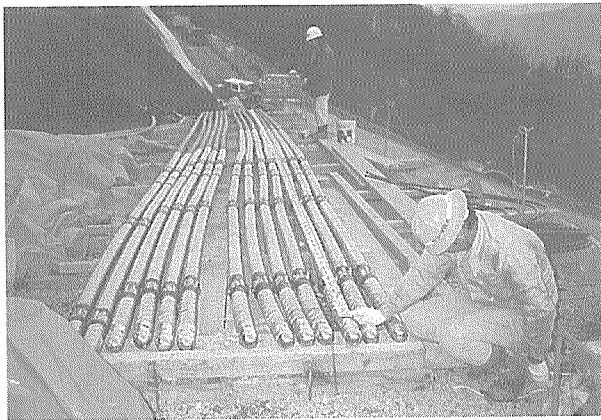
写真-2 SHS 永久アンカー
