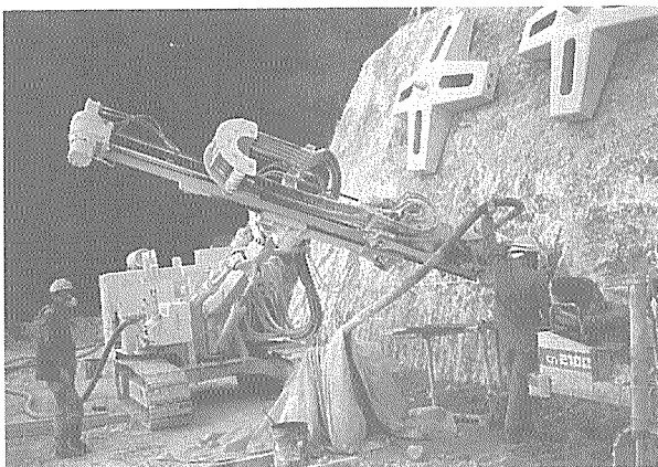
写真-3 アンカー削孔状況
