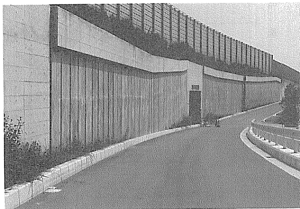
写真-2 道路擁壁例
