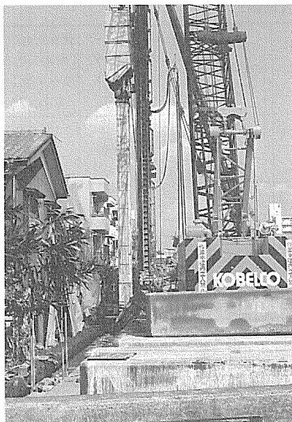
写真-1 施工状況
