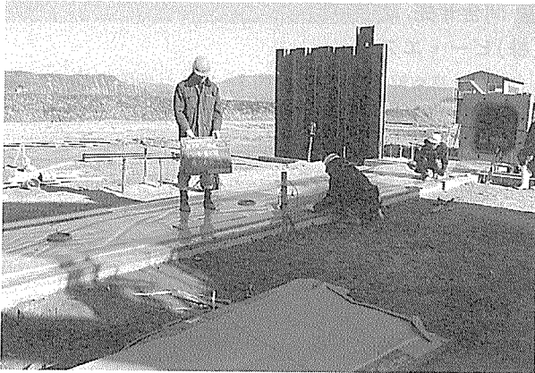
写真-3 設置位置ベース施工
