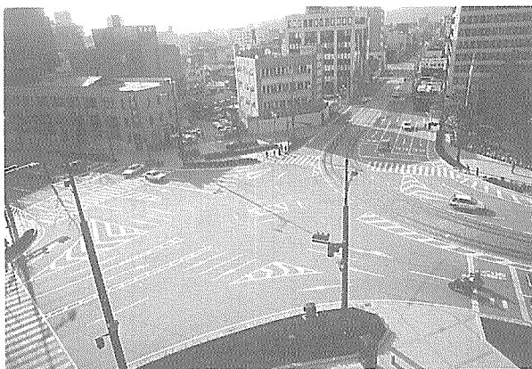
写真-6 辛島町交差点内PCプレキャスト版舗装
