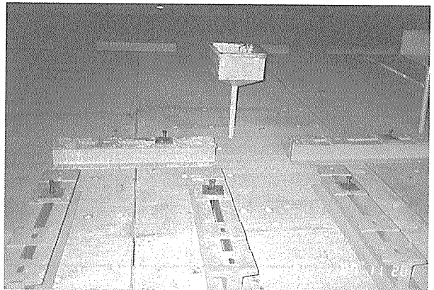
写真-5 段差の調整
