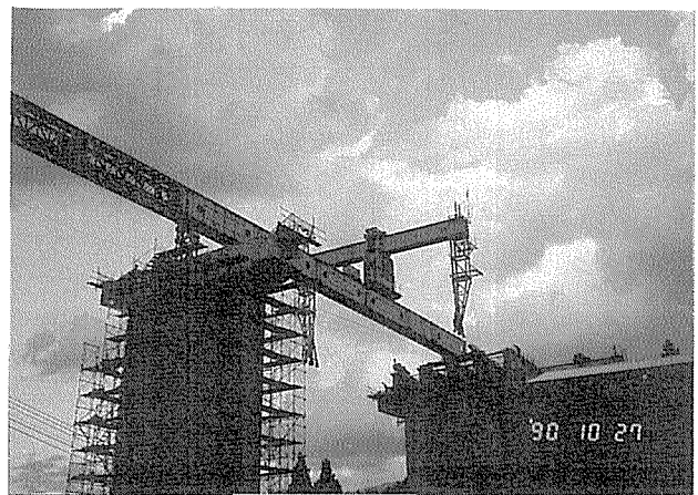
写真-3 横取り用門型クレーン移動
