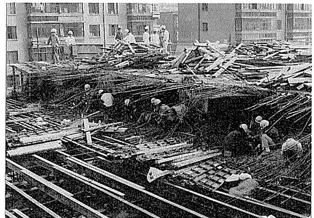
写真-6 打継目の処理
