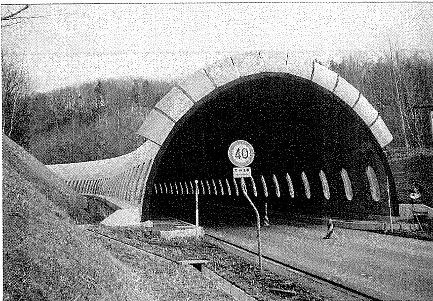
写真-1 完成写真（起点側より）
