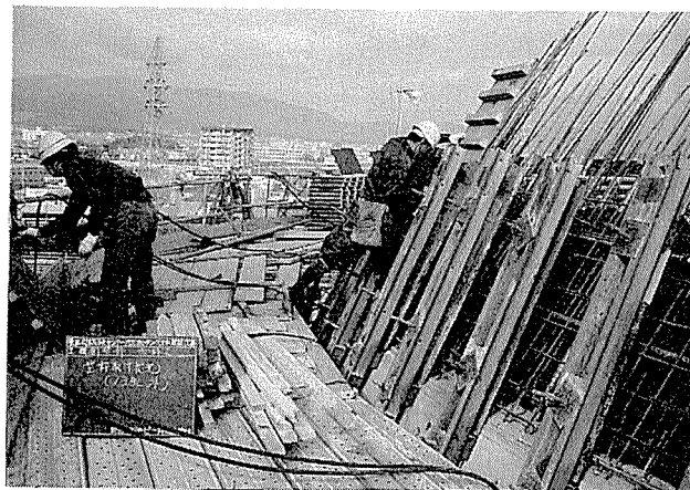
写真-6 クライミング外側型枠設置状況
