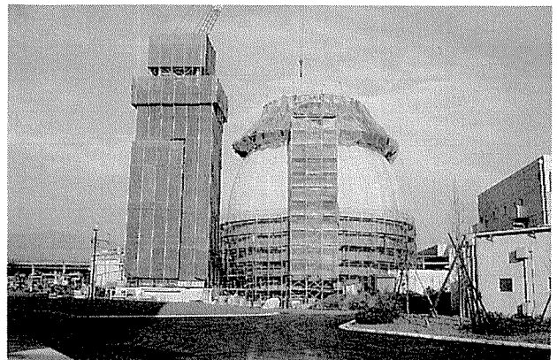
写真-1 側壁部施工状況
