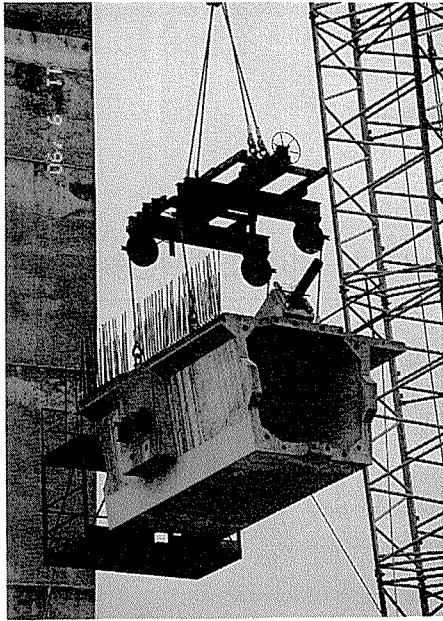
写真-2 プレキャストブロックの架設
