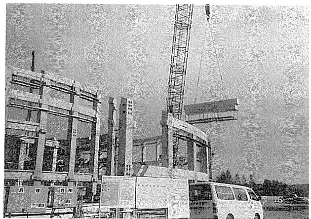
写真-6 円周方向梁架設
