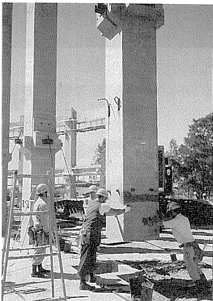
写真-5 柱脚部 (埋込み形式)
