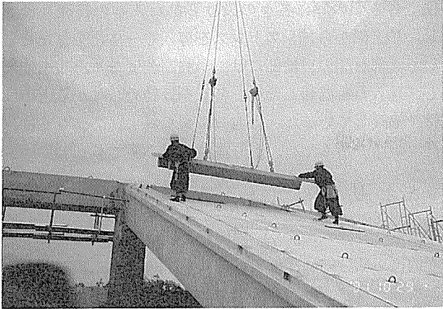
写真-8 屋根版架設
