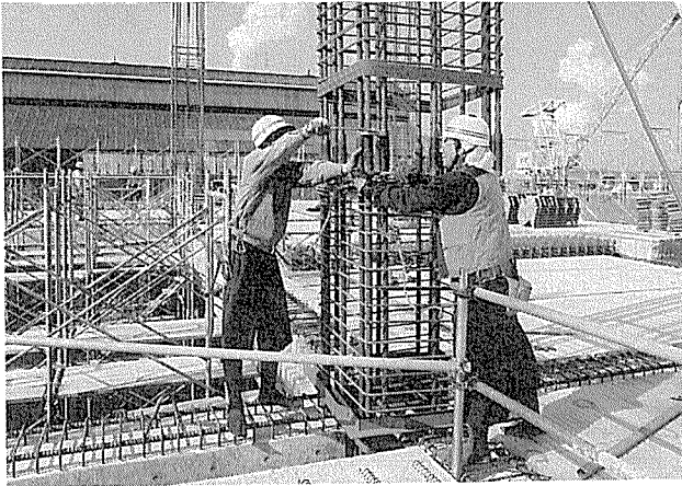
写真-4 組立鉄筋施工状況
