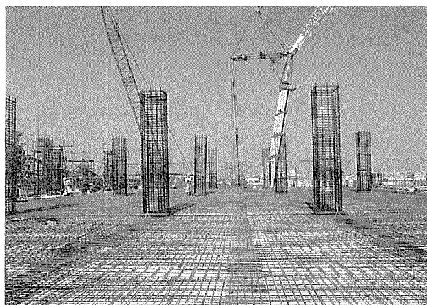
写真-3 トップコンクリート内配筋状況
