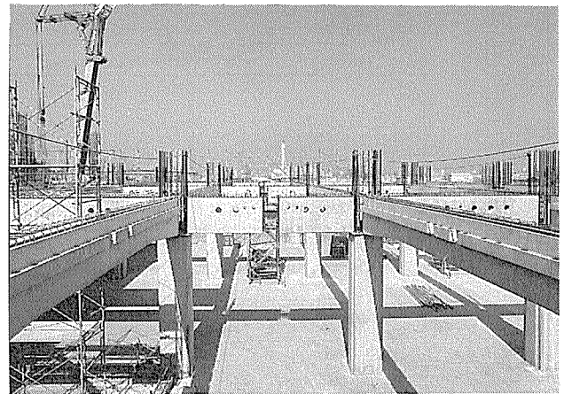
写真-7 PC 梁架設状況
