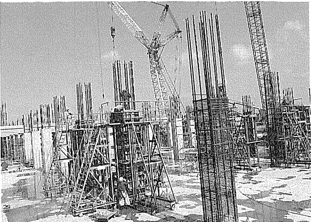
写真-5 柱鋼製型枠施工状況
