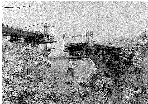
写真-1 架設状況
