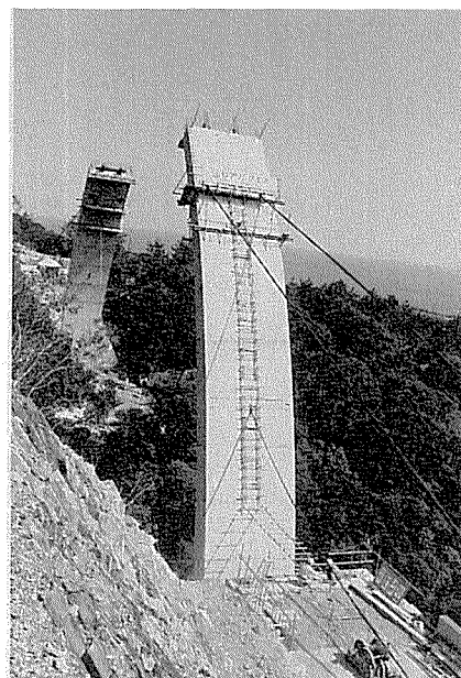
写真-1 鯛之川橋ロアリング架設中
