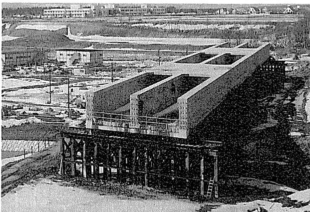
写真-1 水路橋全景 (仮置き時)
