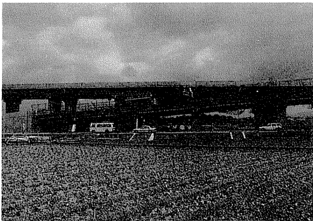
写真-2 試験車の载荷 (中央径間)
