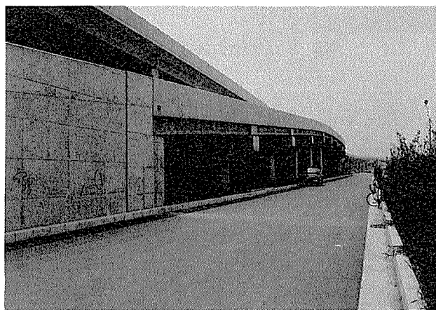
写真-1 測定対象橋梁 (OFF ランプ)
