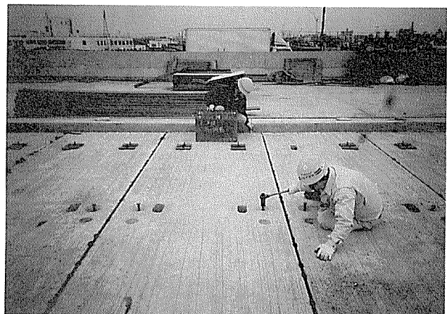
写真-7 プレキャスト床版高さ調整
