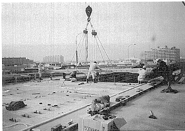
写真-1 プレキャスト床版の施工
