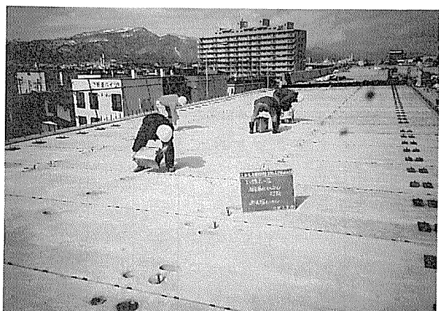
写真-8 目地モルタルの施工
