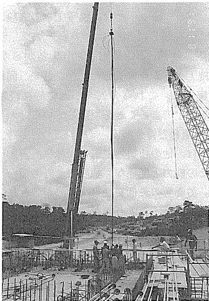
写真-4 グラウンドアンカー挿入作業
