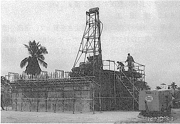
写真-3 グラウンドアンカー削孔作業
