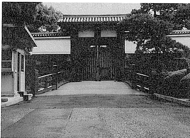
写真-4 新北桔橋正面
