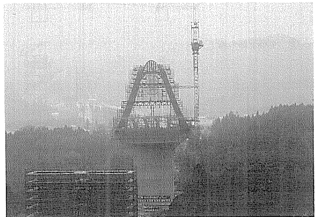
写真-4 主塔施工状況
