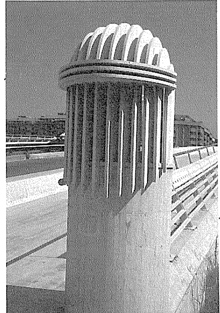
写真-3 バック・デ・ローダ橋の親柱
