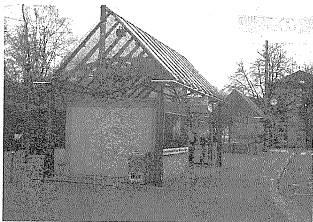
写真-19 サン・ガレンの地下道上屋
