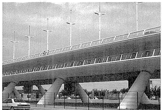
写真-8 アラミージョ橋に連続する高架橋
