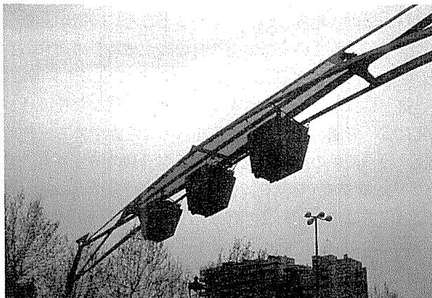
写真-17 バルセロナの門型道路標識柱
