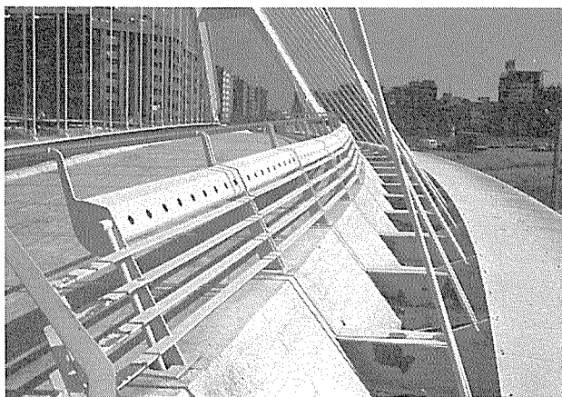
写真-2 バック・デ・ローダ橋
