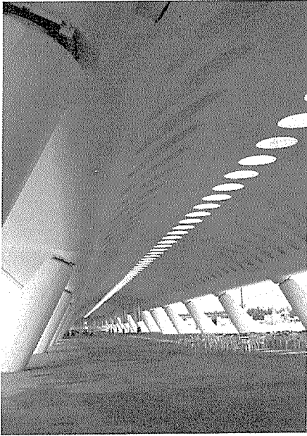
写真-9 アラミージョ橋に連続する高架橋の桁裏
