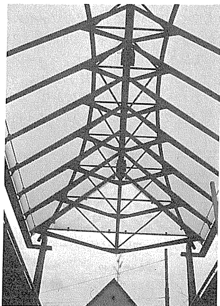
写真-20 地下道上屋の天井部分
