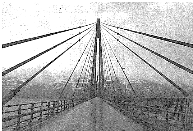
写真-2 ヘルゲランド橋 主塔およびケーブル配置
