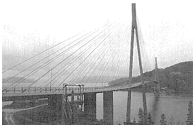
写真-3 スカルンズンド橋 全景
