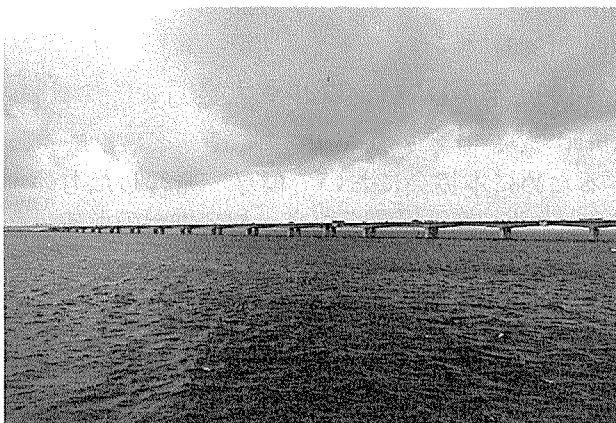
写真-7 グレートベルト（ウエスト橋）21径間架設完了
