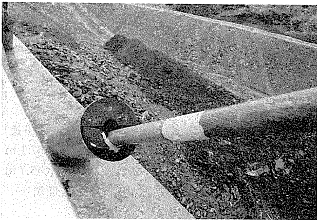
写真-5 スカランズンド橋 斜材定着部
