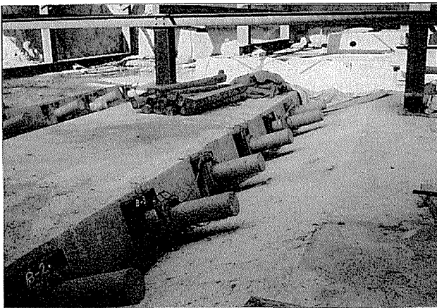
写真-2 グラウンドアンカー設置状況
