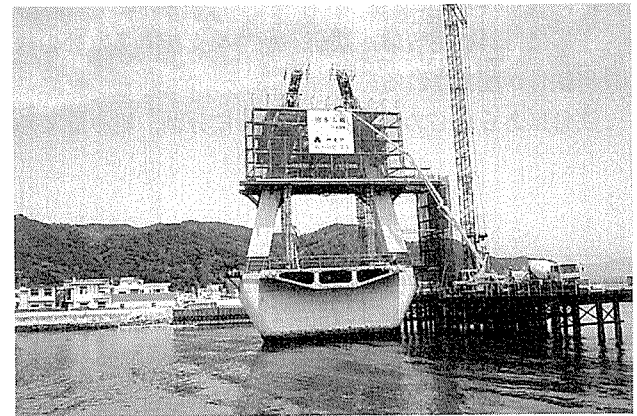
写真-5 主塔コンクリート打設
