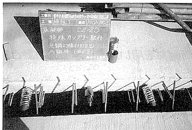
写真-9 特殊カップラーによる横締め鋼材連結状況
