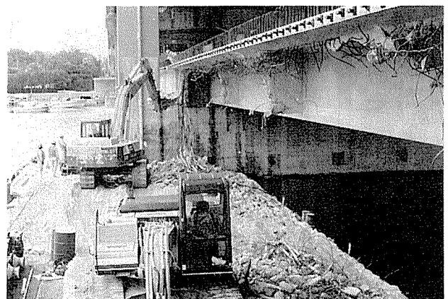
写真-6 台船・圧碎機による桁撤去状況
