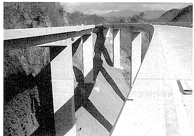
写真-10 完成 (全景)
