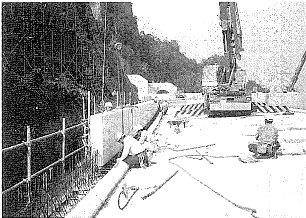
写真-3 プレキャスト部材据付け
