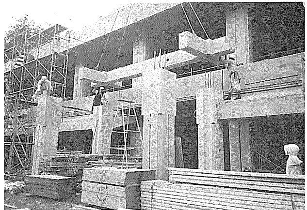
写真-10 玄関部十字梁架設
