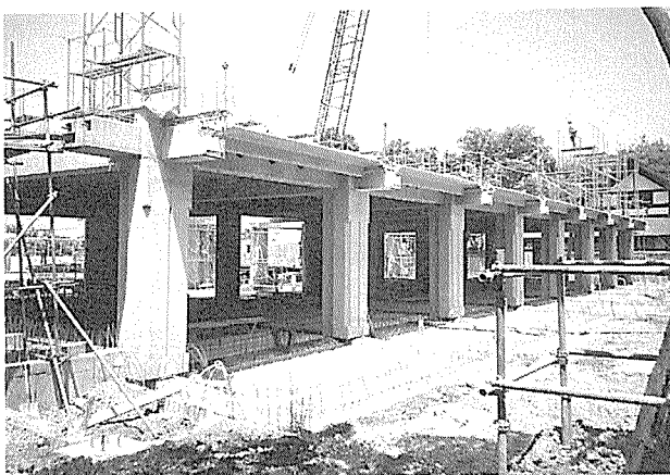
写真-8 桁梁緊張
