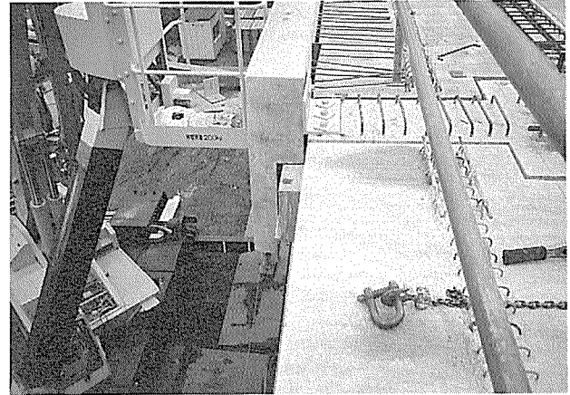
写真-9 鼻梁架設
