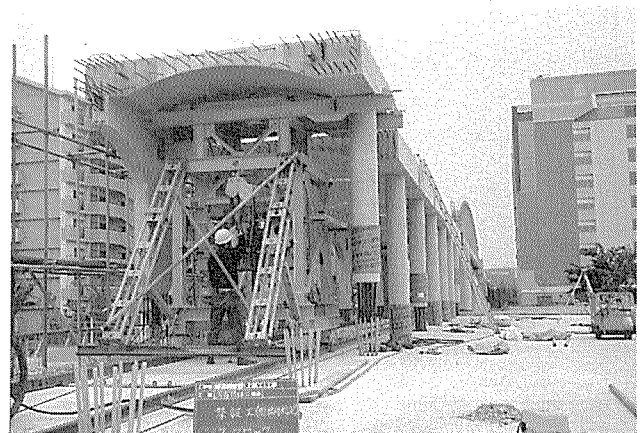
写真-8 部材据付け状況
