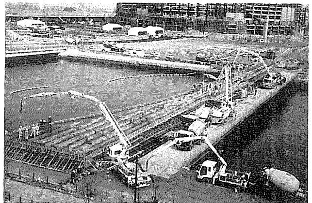
写真-4 主桁コンクリート打設状況
