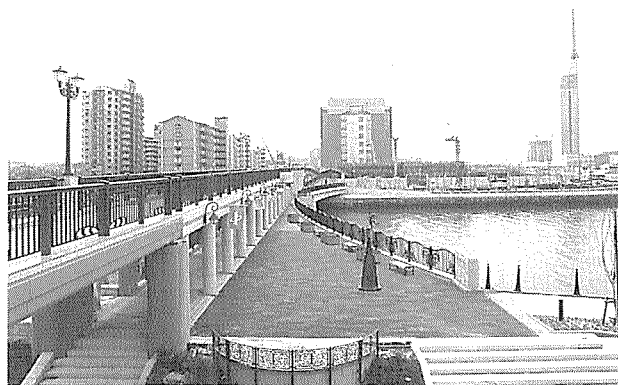
写真-2 全景(下流側)
