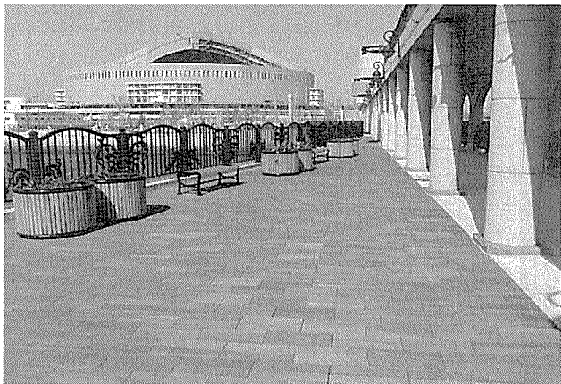
写真-9 木製ブロック舗装
