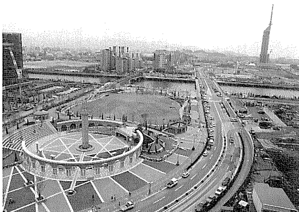
写真-13 「ふれあい橋」周辺
