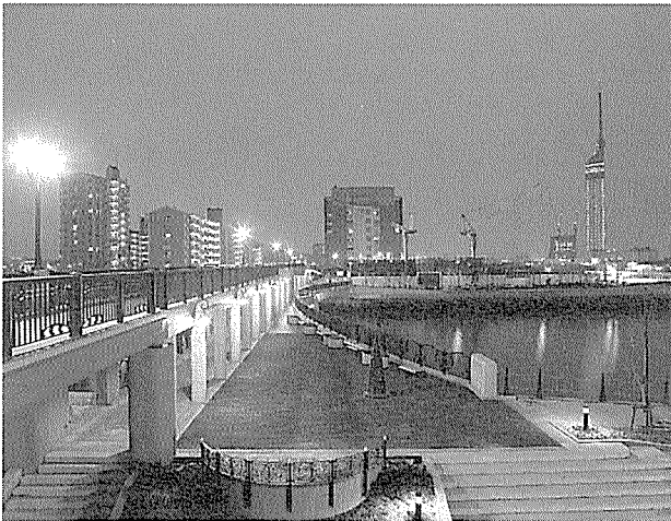
写真-14 夜間の「ふれあい橋」
