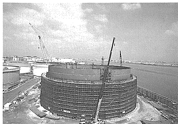
写真-4 PC 側壁工事 (第4~9 ロッド)
