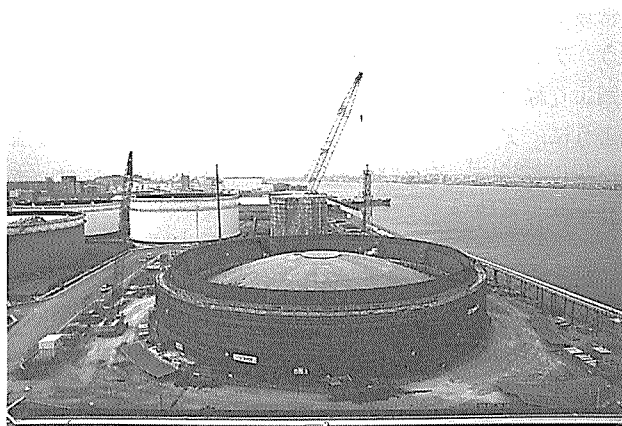
写真-3 PC 側壁工事 (第1~3 ロッド)
