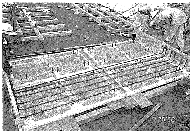
写真-4 PIC フォーム組立状況
