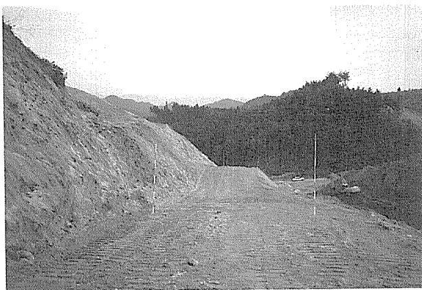
写真-2 サグ勾配確認状況
