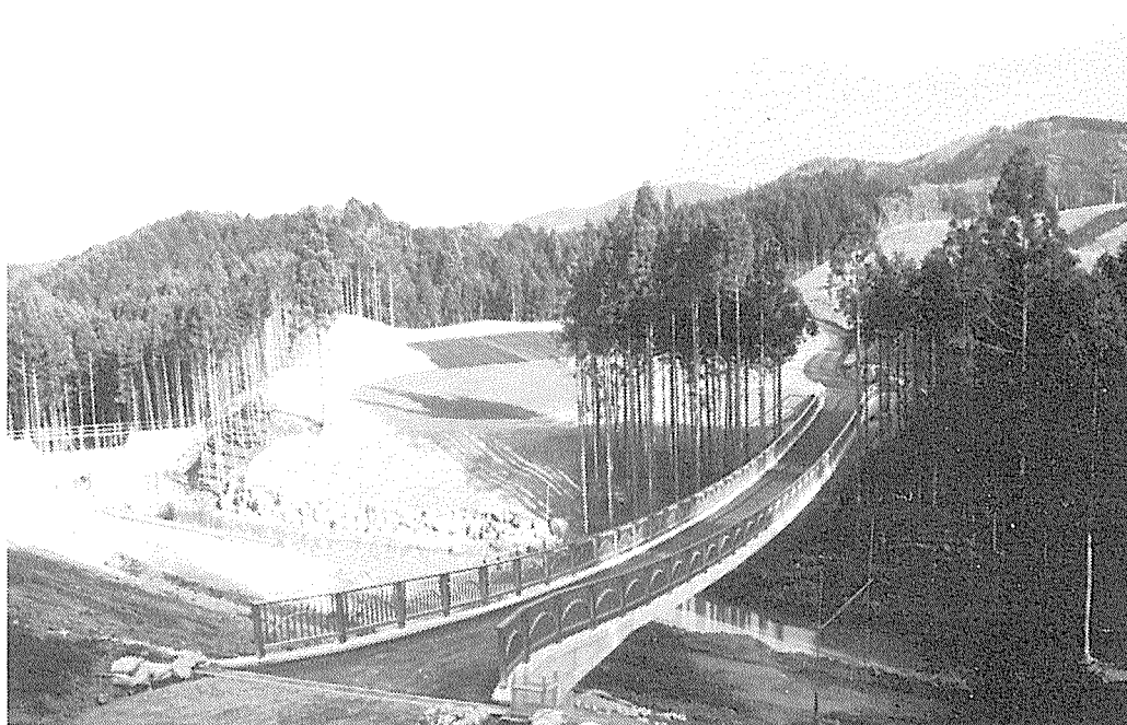
写真-1 つくで C. C. 吊床版橋
