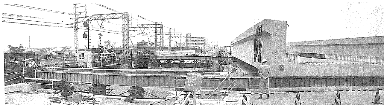
写真-5 主桁横移動状況(S 1 径間)
