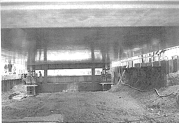
写真-8 主桁ジャッキダウン準備完了 (S 1 径間, A 1 橋台)
