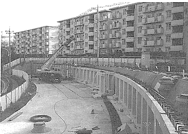
写真-4.3 プレキャスト柱架設
