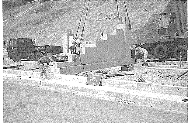
写真-2.1 基礎・柱・壁一体化部材
