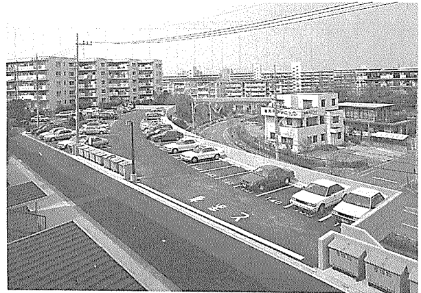
写真-4.1 完成(屋上)
