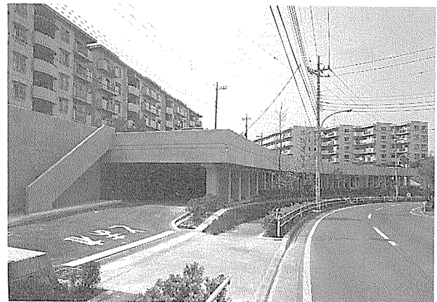
写真-4.2 完成(入口)
