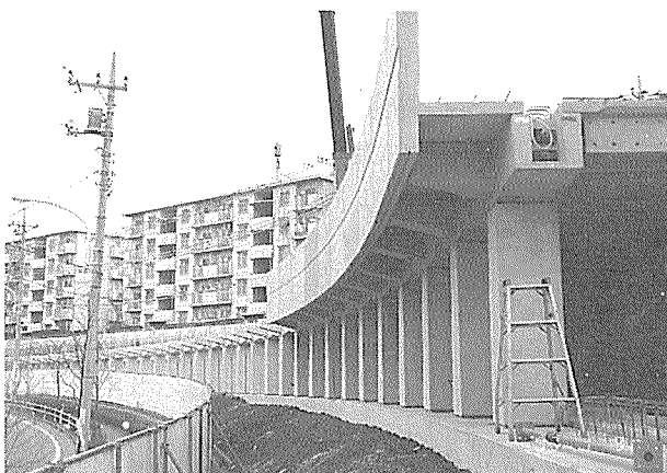
写真-4.4 床版・手すり版取付け
