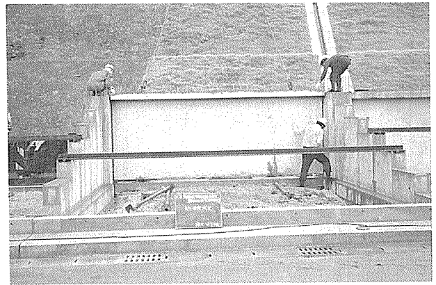
写真-2.2 桁行壁取付け
