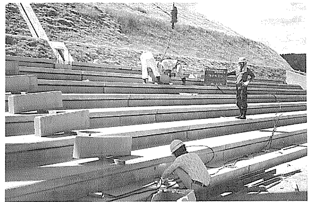
写真-2.3 PC段床版敷設中
