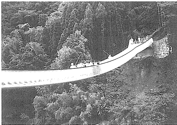
写真-2 静的載荷状況（中央集中載荷）
