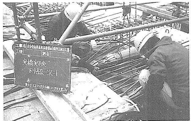
写真-2 プレストレス導入時測定状況
