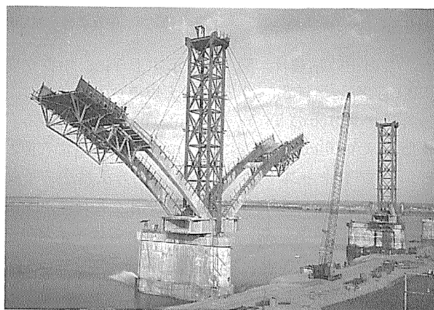
写真-2 The III Godavari 橋の架設
