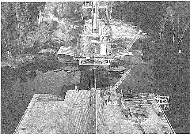
写真-2 チェコの Elbe 川に架かる PC 斜張橋の架設状況
