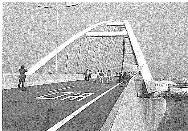
写真-16 阪神高速湾岸線「新浜寺大橋」にて
