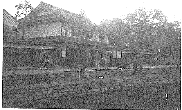
写真-19 倉敷美観地区にて
