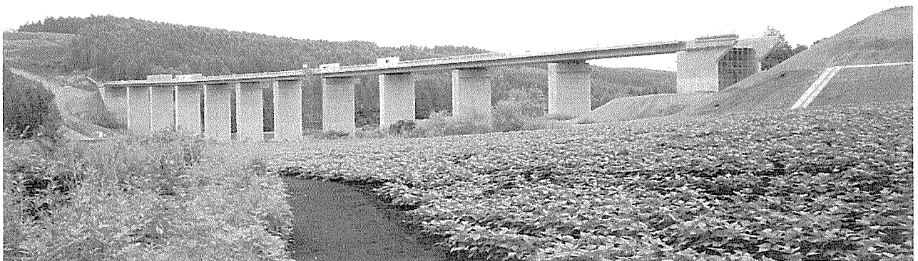
写真-1 北明橋全景
