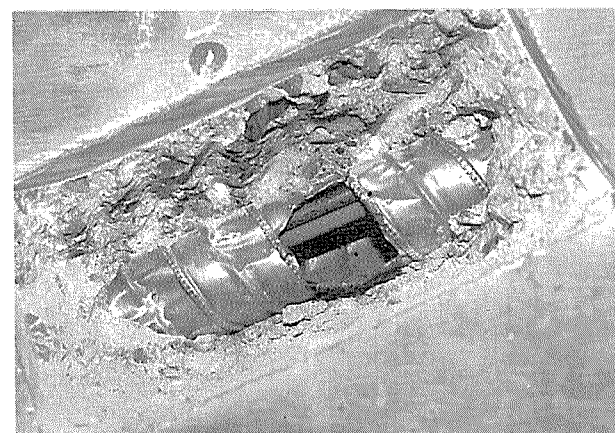
写真-2 はつり出しによるグラウト調査例
