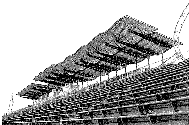
写真-2 前方より屋根を見上げる
