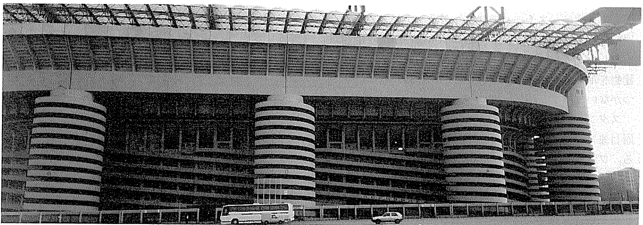
写真-6 スタジアム外観
