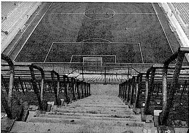
写真-3 勾配が急な3階スタンド
