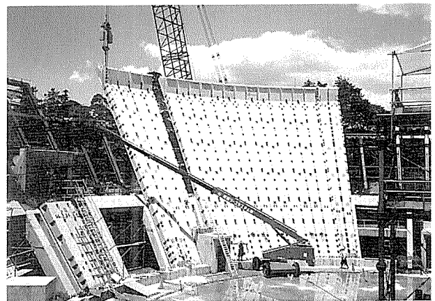
写真-6 架設状況 (その2)
