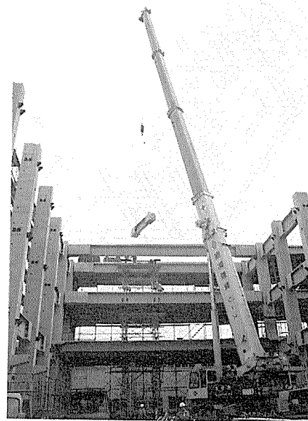
写真-3 桁梁架設
