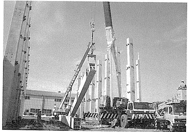
写真-2 柱架設
