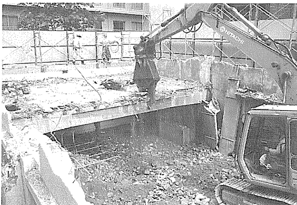
写真-9 DTスラブとPC梁は圧砕機で容易に解体
