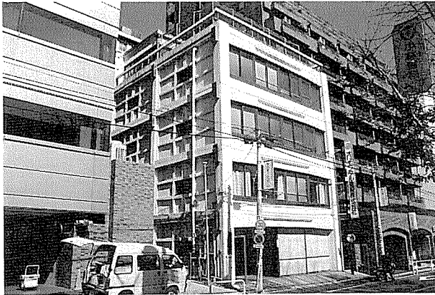
写真-1 解体が決まった頃の Pca. PC の建物
