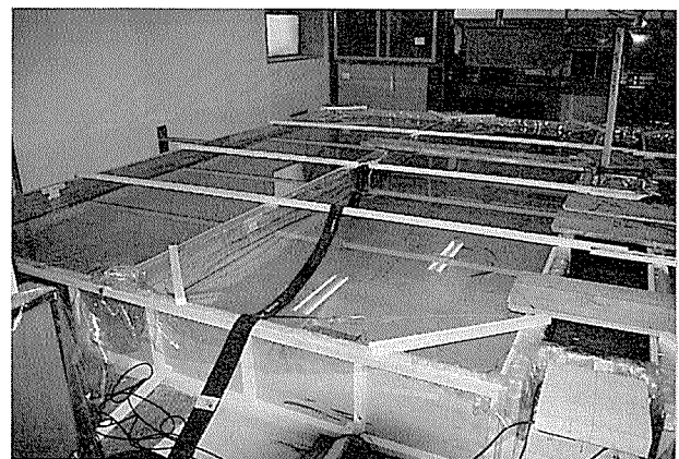
写真-8 水張り載荷用の簡易プール 水深30cm
