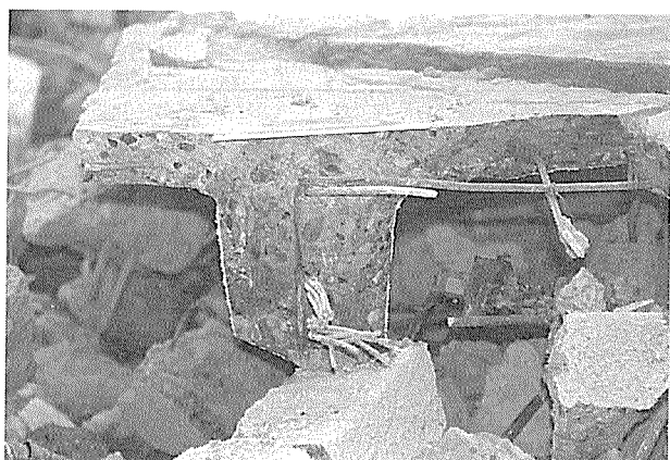
写真-13 DT スラブの中性化 約 2 mm 程度
