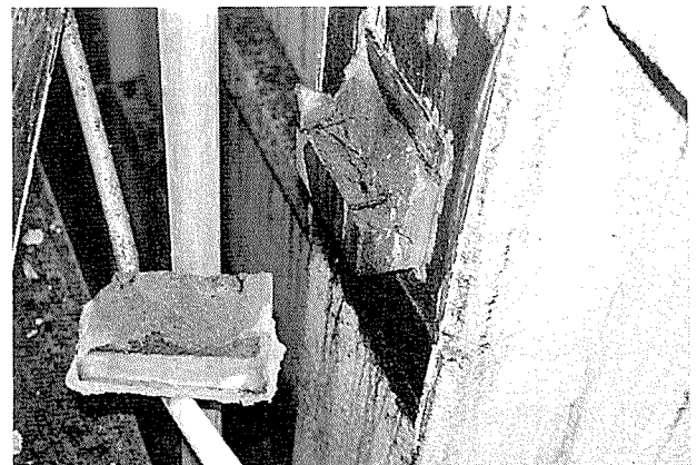
写真-6 PC 鋼棒定着端の保護モルタルと補強筋
